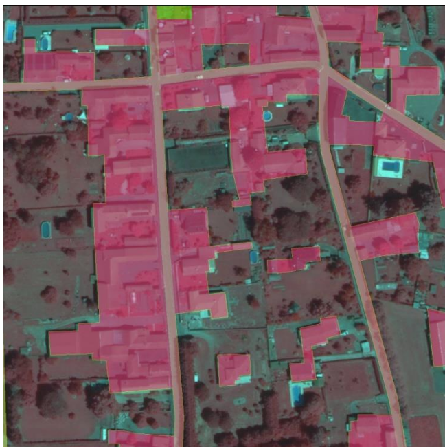
Figure 18 : construction de la zone bâtie
